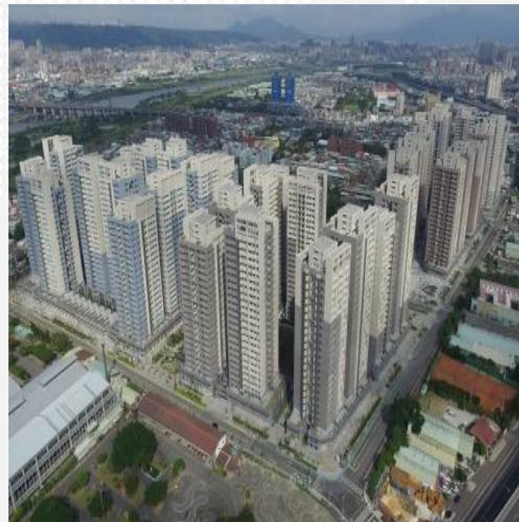
板橋浮洲合宜住宅
