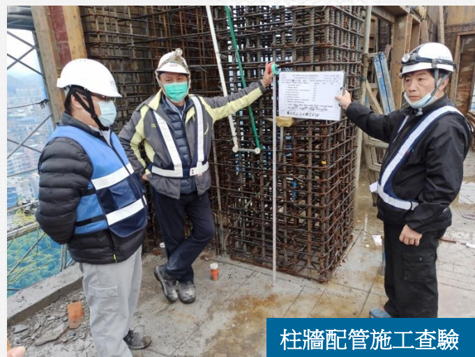
隔間配管施工查驗
